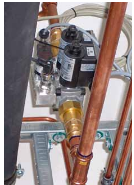
Die Laborabsperrarmaturen sind in der Regel nah bei der Bedieneinheit in der Zwischendecke der Laborräume installiert. Vorteil bei beengten Platzverhältnissen: Die Absperr- oder Laborarmaturen lassen sich dabei vertikal oder horizontal montieren.
